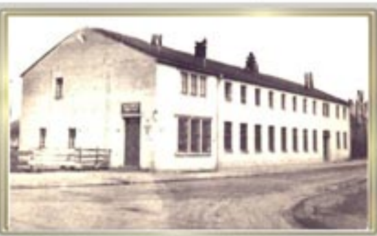
Wiederaufbau 1948 Saalbetrieb B. Jansen Hauptstrasse 26
